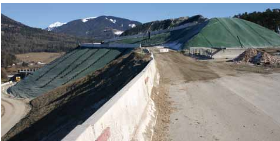
Mülldeponie: Aufwändig saniert, dennoch leiden die Brunecker Ossis oft unter beißendem Gestank Foto:rewe
