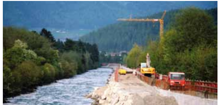
Dammsicherung zwischen Bruneck u. St. Lorenzen
