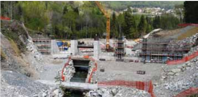
Rückhaltesperre bei Percha
