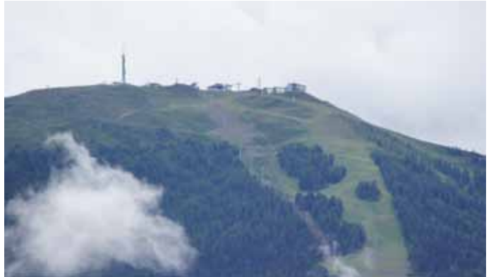
Am Kronplatz ist für den Anschluss der Ried-Piste bereits alles vorbereitet. Diverse Vorarbeiten wurden bereits umgesetzt, um keine Zeit zu verlieren Foto: rewe
