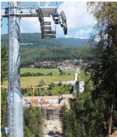
Anfang Oktober erfolgt der Seileinzug
