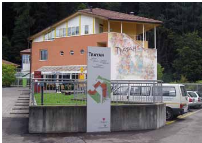
Das Sozialzentrum Trayah wird ebenfalls erweitert
