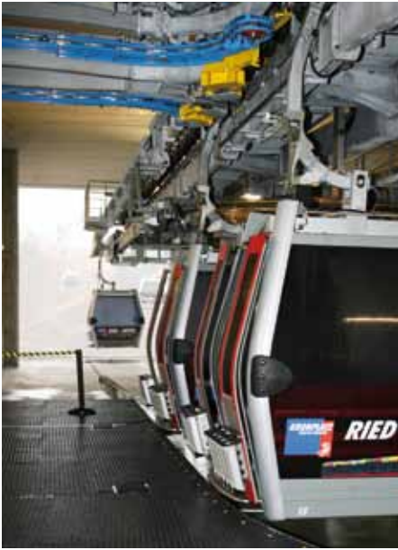
1. Tag: Hinaus vom Bahnhof, hinein in den Nebel Foto: wpz
