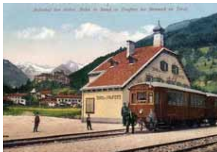
jede Richtung, die Fahrt dauerte rund 50 Minuten. Der Wagenpark bestand aus zwei Triebwagen und zwei Beiwagen, die von der Grazer-Waggonfabrik geliefert wurden und je 50 Personen fassten. Da die Strecke nur eingleisig, ohne entsprechende Ausweichen eingerichtet war, konnte sich nur jeweils ein Zug auf der Strecke befinden. Der Fahrpreis für Hin- und Rückfahrt betrug in den ersten Jahren zwei Kronen, womit laut „Der Tiroler“ die Tauferer-Bahn die teuerste ganz Tirols war. Allerdings war die Bahn im Verhältnis zur Kutsche billig. Der durch den Bahn-Bau bedingte „kolossale, geradezu amerikanische Aufschwung Tirols in puncto Fremdenverkehr“ veranlasste den
